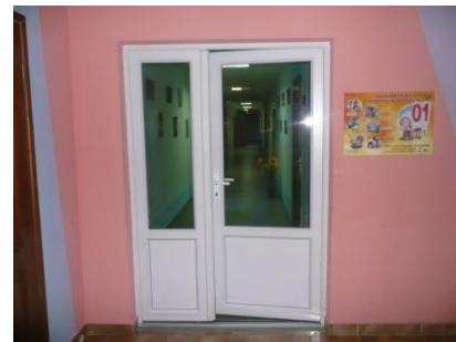
Фото 9. Дверь внутри здания
