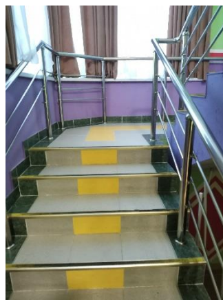
Фото 8. Лестница внутри здания
