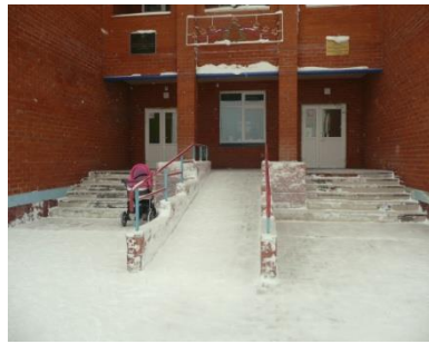
Фото 2. Пандус и лестница наружная
